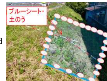
写真:「はらみ出し」の応急対策例
