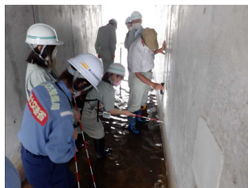
写真:函体内部の変状確認の実習
