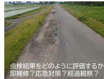
写真:堤防天端の荷重による沈下
